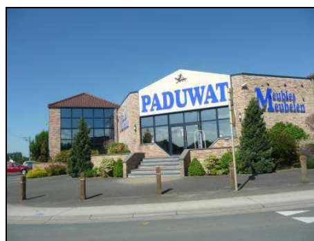
Figure 747 : Photographie d'un magasin d'ameublement, à Bierghes
